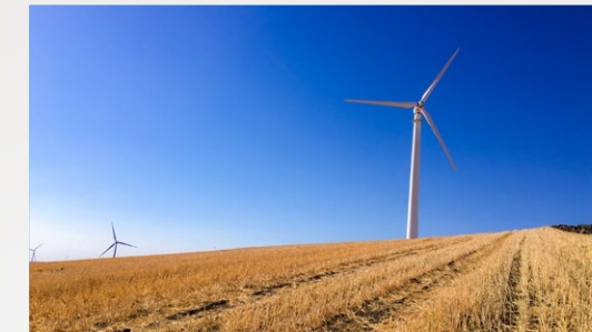
Impianto Eolico da 60 kWe
